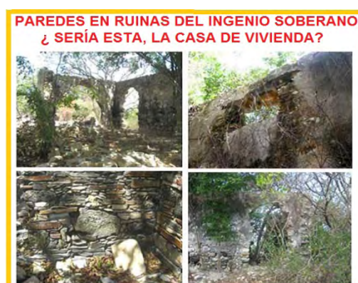
Figura 4- Ruinas actuales del Ingenio Soberano.
