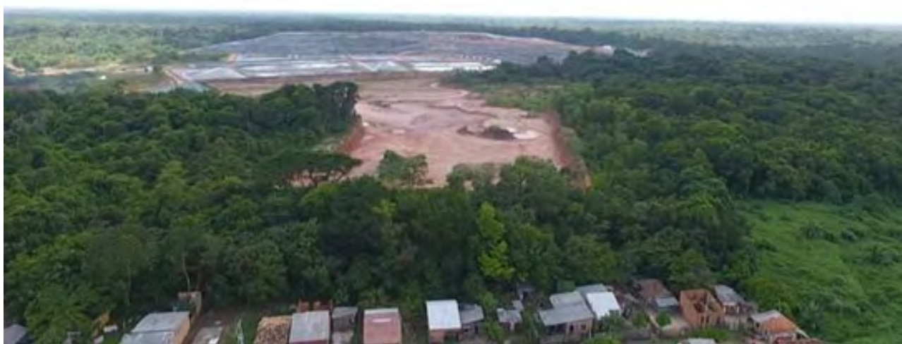
Figura 1 -Aterro sanitário próximo de residências domésticas
